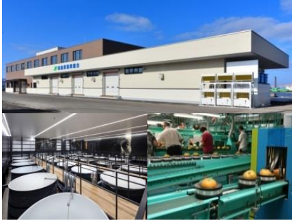
⑰⑱ 集出荷・貯蔵・加工施設
