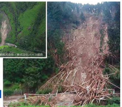
風倒木の被害地の崩壊を起因とした土砂と立木の流出
