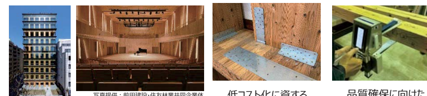
CLTを活用した先駆的な建築物の実証
