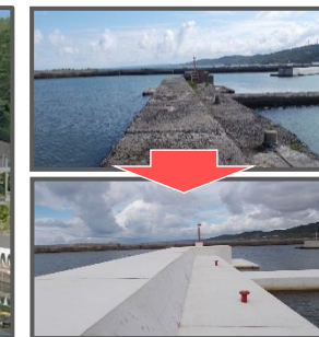
漁港施設の長寿命化対策
