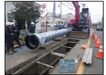
(耐震管の敷設工事)
