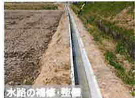
水路の補修・整備
