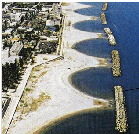
離岸堤に波が当たり消波することによって越波を減少させ、また、漂砂を抑制することによって汀線の維持・回復を行う
