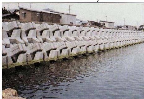
外海から侵入する波のエネルギーを減殺して、堤防等の構造物に作用する波の力を小さくする
