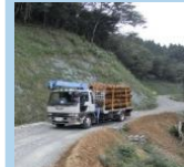
幹線となる道の整備
