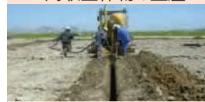
《実証ほ場の設置》
