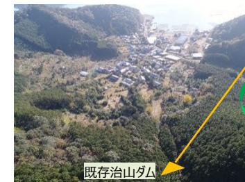
既存治山ダム
