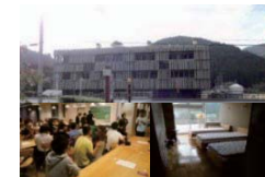
廃校を利用した交流施設
