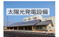
太陽光発電設備
