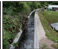
老朽化した用水路の整備・更新
