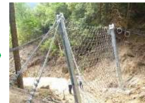
簡易な構造物による応急対策
