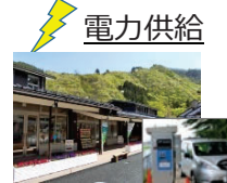
EV車等への給電設備
