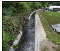
老朽化した用水路の整備・更新
