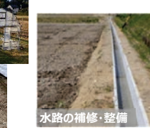
【水路の補修・整備】
