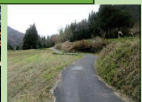
農作業道の舗装
