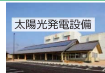
太陽光発電設備
