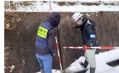
激甚災害後の治山施設の点検支援
