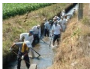
水路の泥上げ
