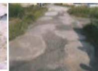
農道の窪みの補修
