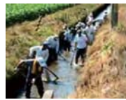
水路の泥上げ
