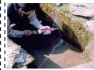
水路のひび割れ補修
