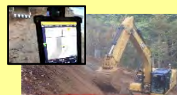
ICT建機による土工
