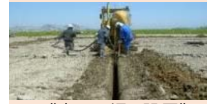
《実証ほ場の設置》
