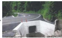
排水工の設置
