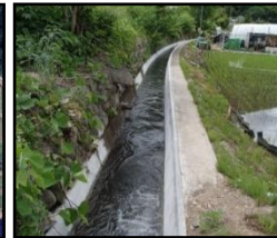
老朽化した用水路の整備・更新
