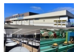
集出荷・貯蔵・加工施設
