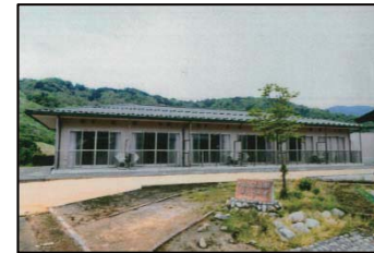
生坂村 生活支援ハウス
