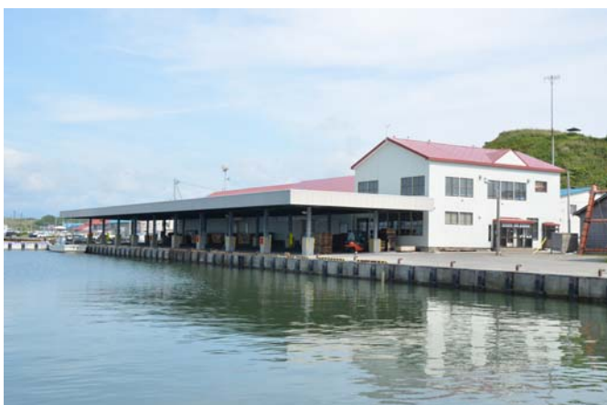
整備された屋根付き岸壁
