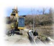
U字溝設置
